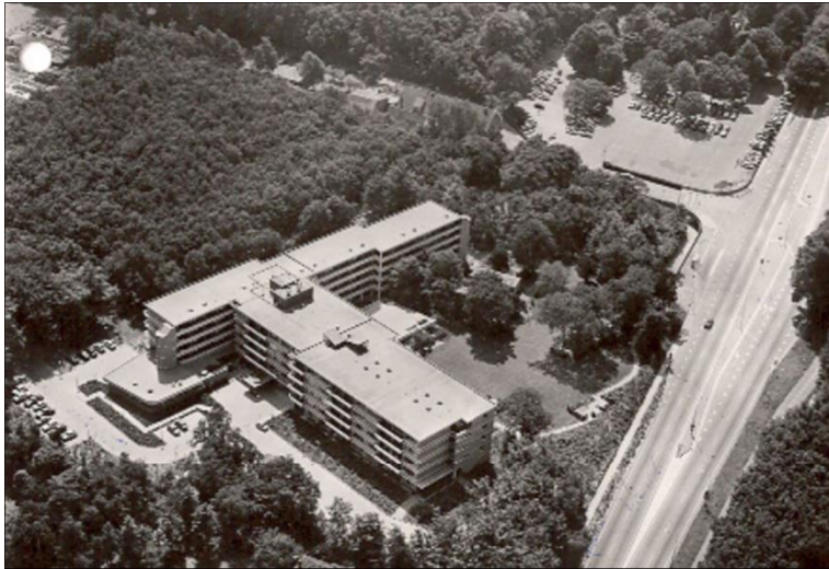
Afb. 2 Serviceflat "Zomerland-Wassenaar", rechts Rijksstraatweg N44
